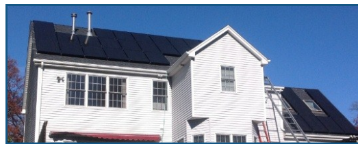
(36) 250-Watt Solar Panels
